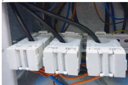
Transformadores de corriente para cables montados en perfil DIN
