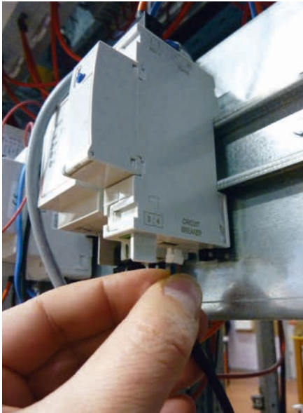
Conexión mediante la interfaz de comunicación. El cable de conexión se entrega junto con la interfaz.
