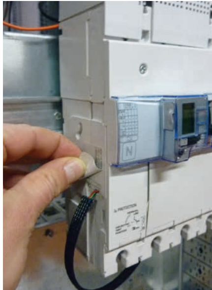
Conexión en el lado izquierdo del DPX 3 , debajo de la etiqueta.
