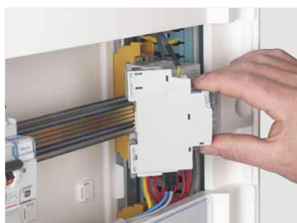
CONEXIÓN MEDIANTE PERFIL
