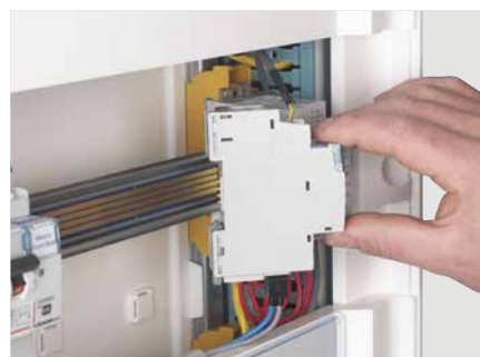
CONEXIÓN MEDIANTE PERFIL
