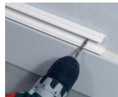
2 Clavar o atornillar de acuerdo al material de la pared.
