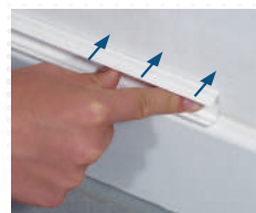
2 Coloque la minicanaleta en la posición deseada y presione firmemente contra la pared. El espesor de la espuma adhesiva compensa cualquier defecto en la pared.
