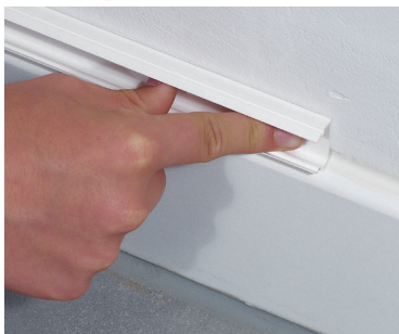
1 Colocar la minicanaleta sobre la pared.
