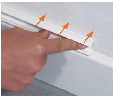
2 Coloque la minicanaleta en la posición deseada y presione firmemente contra la pared. El espesor de la espuma adhesiva compensa cualquier defecto en la pared.
